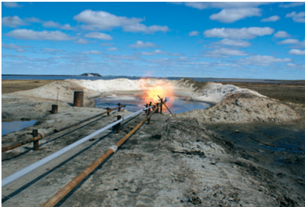
Идет испытание разведочной скважины на Песцовом месторождении (фото С. Мильшина).
